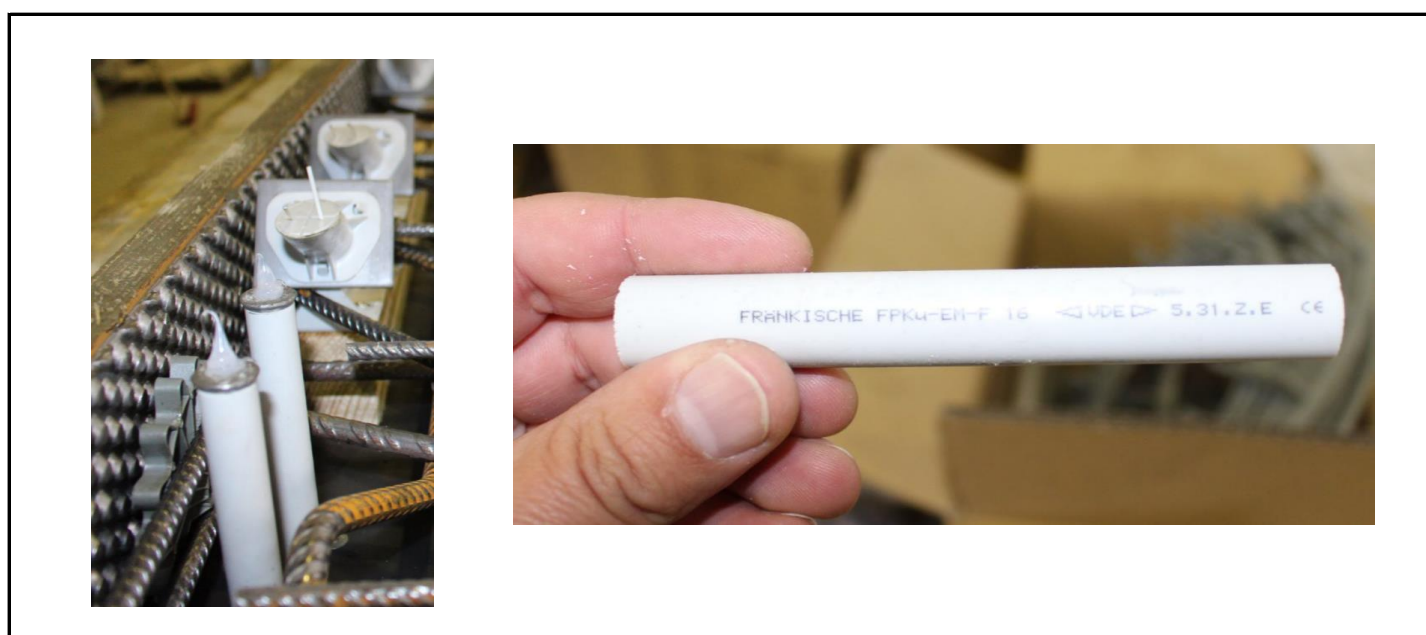
Abb. 25 - 26: Schraubkanäle 90° für ASSY® 3.0 SK Schrauben
