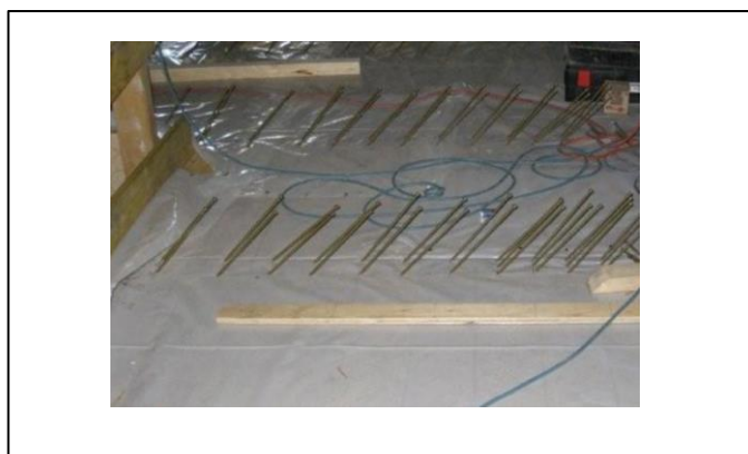
Abb. 2: Zum setzen vorbereitete ASSY plus VG Ø 8mm Zylinderkopfschrauben
