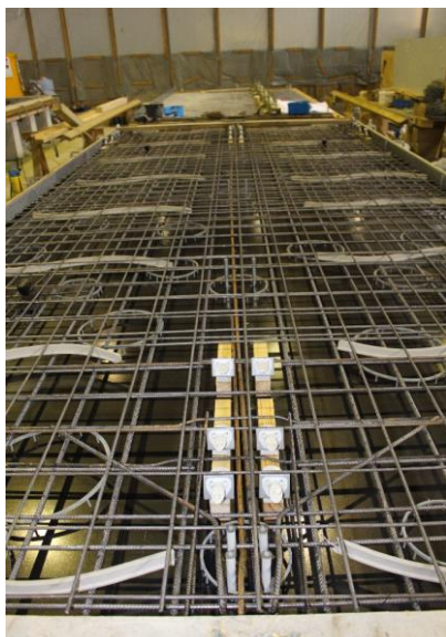
Abb. 21 - 22: Beispielhafte Anbringung von FT-Verbindern im Fertigteilwerk
