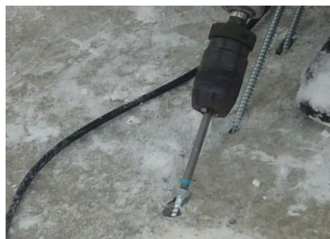
Abb. 14: Verschraubung der ASSY plus VG Schrauben
