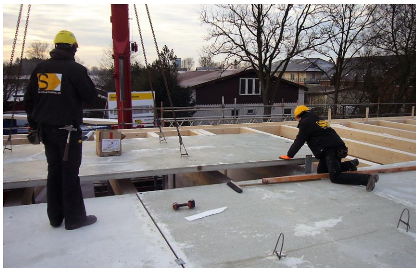
Abb. 30 - 31: Beispielhafte Anbringung von Transportschlaufen.
