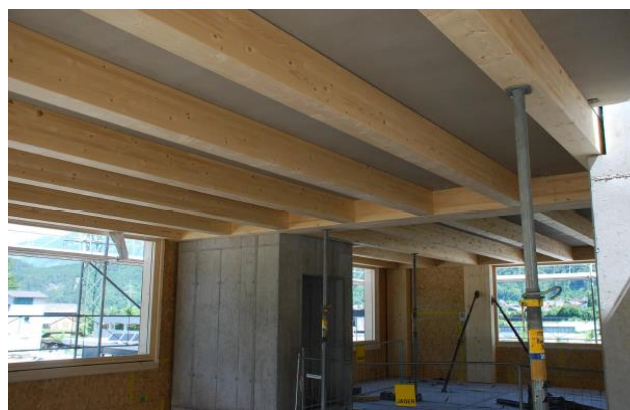
Abb. 12 -13: Verlegung von Betonfertigteilelementen (sichtbare Unterdecke mit integrierten FT-Verbindern auf einer Balkenlage)
