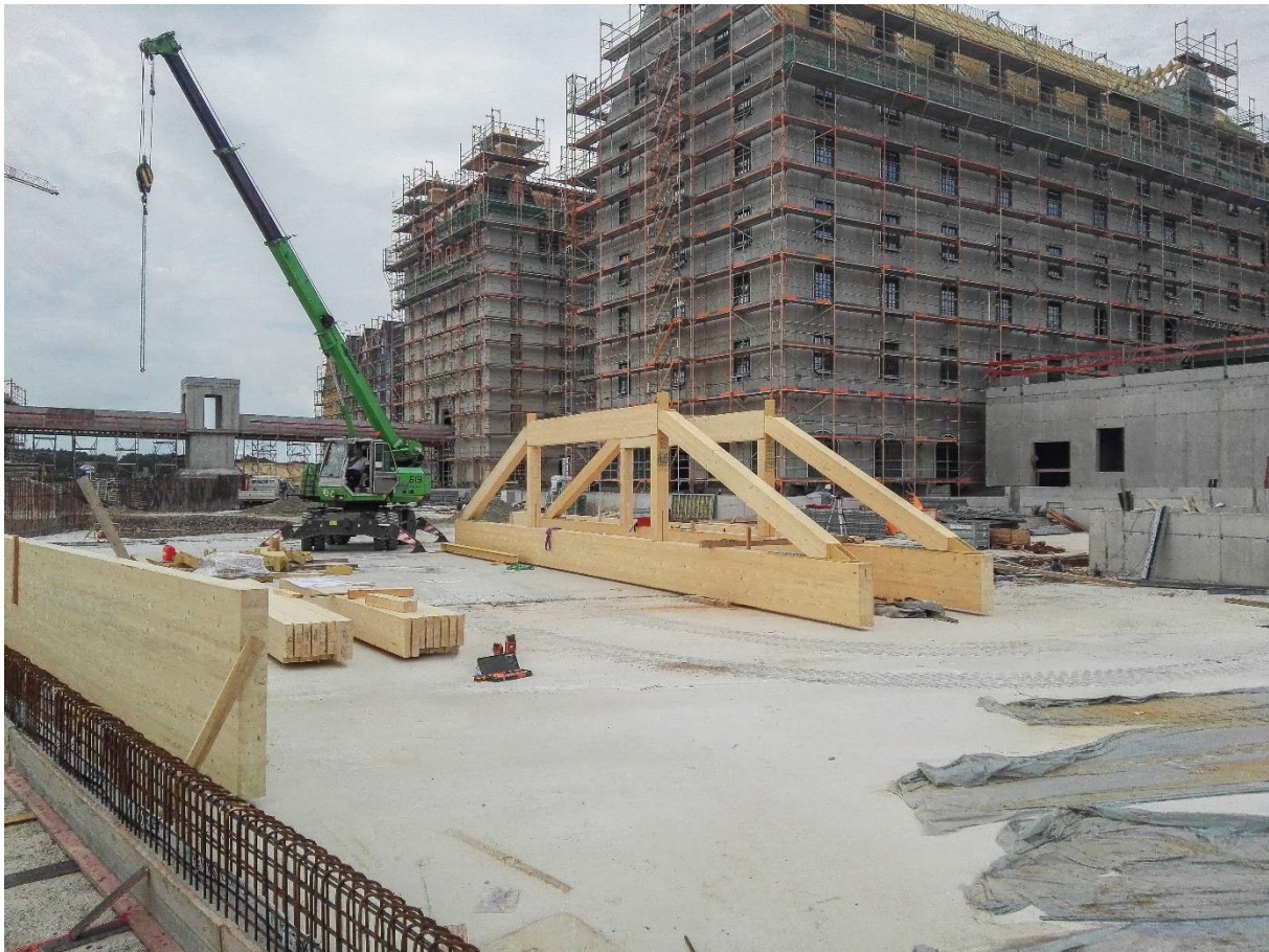
Bild 1: Zweifach überspannter Fachwerkträger vor der Montage
