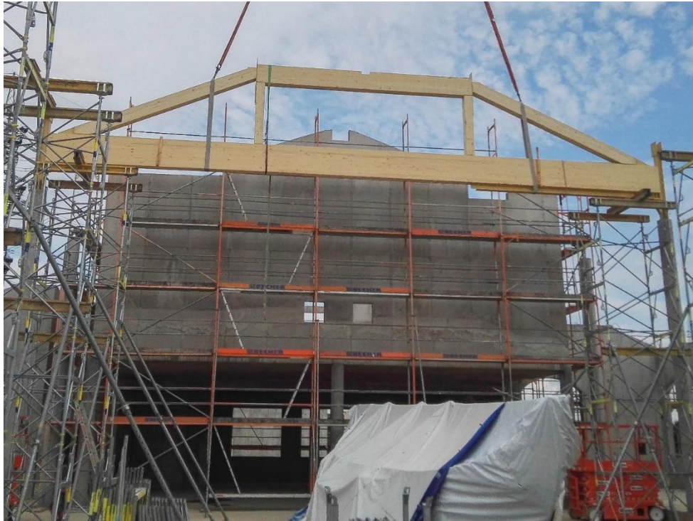
Bild 2: Zweifach überspannter Fachwerkträger während der Montage
